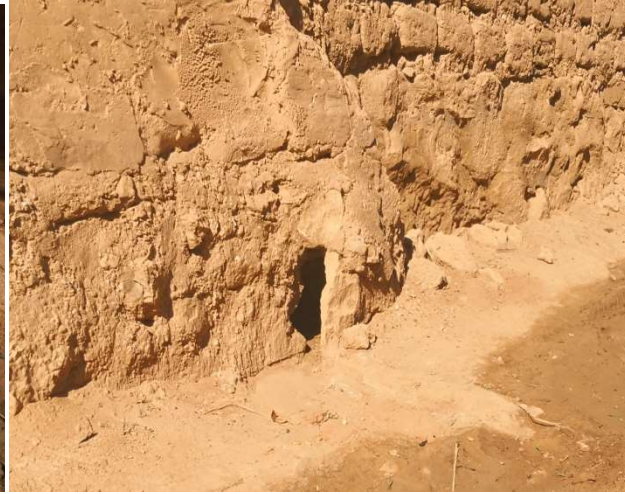
الصورة رقم 42: توضح الكوة
