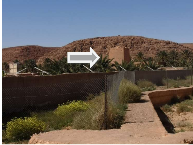
الصورة رقم 25: توضح برج من أبراج الواحة
