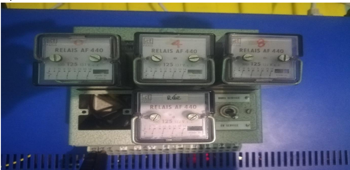
Fig.III.9 : Relais associés au disjoncteur de coupure.
