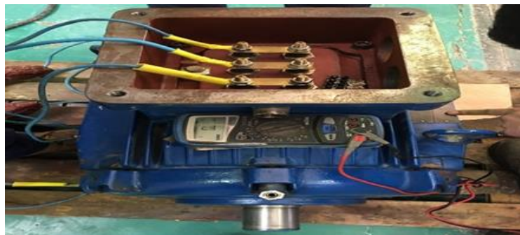
Figure III.23 Mesure des températures avec multimètre.
