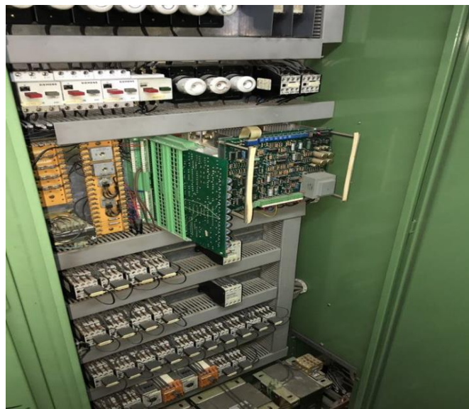
Figure II.17 Armoire de commande automatisé avec une carte électronique.
