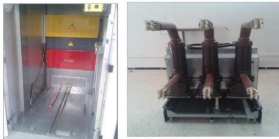
Fig.I.15. Compartiment disjoncteur. [12]
