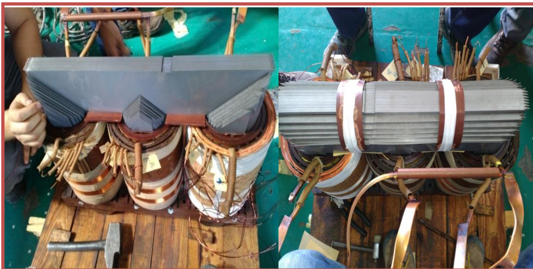
Fig. III.18 : Assemblage du circuit magnétique du transformateur
