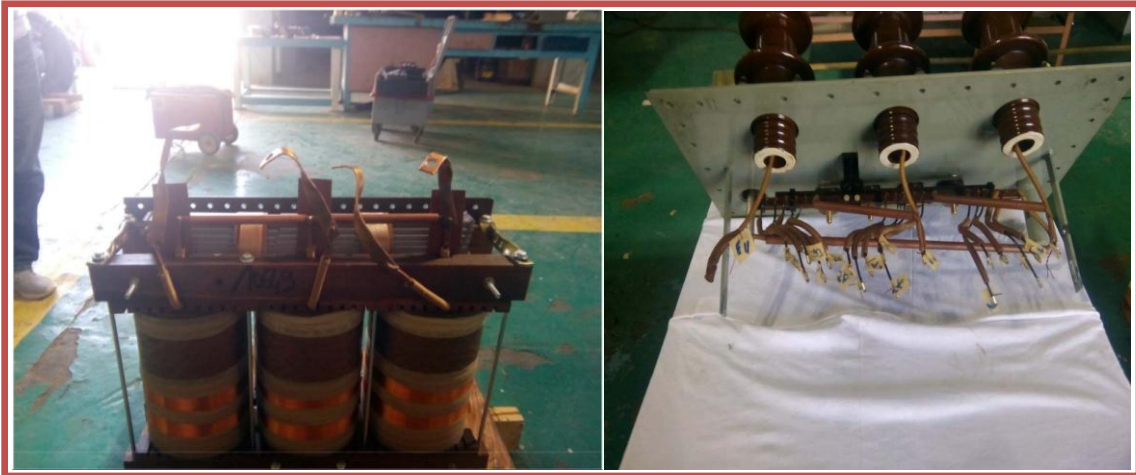
Fig. III.10 : Séparation et enlèvement de la partie supérieure du transformateur.
