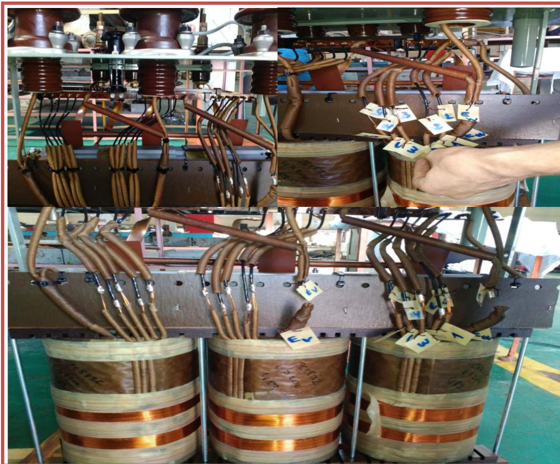
Fig. III.9 : Repérage des fils de connexion pour déconnection les câbles du bobinage.
