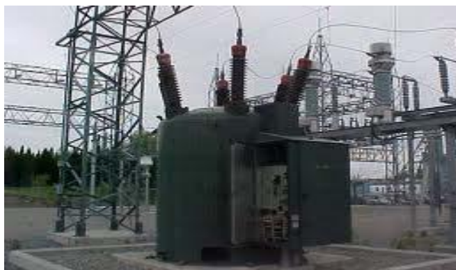
Fig. I.3 : Autotransformateur
