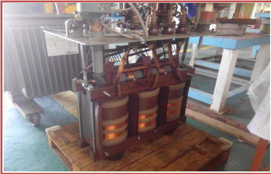
Fig. III.8 : Dépose de la partie active de transformateur MT/BT
