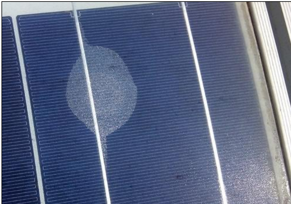
Figure III - 1. Dégradation du module photovoltaïque par délamination
