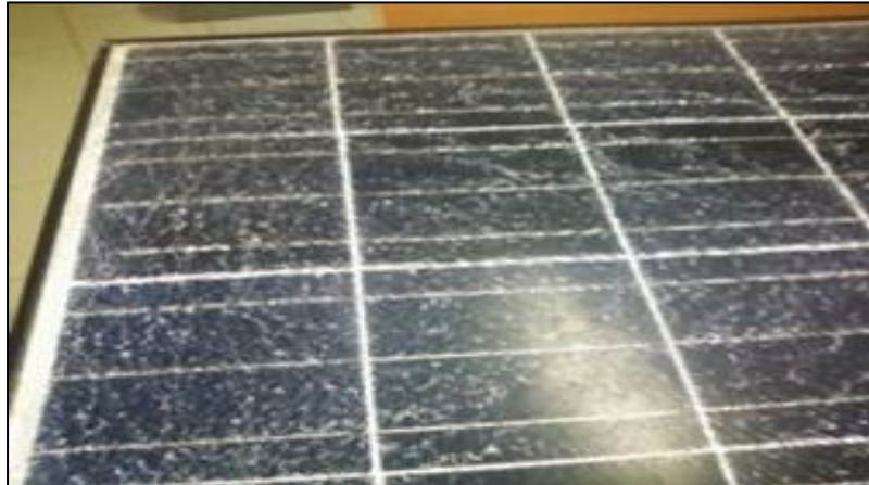
Figure I-23. Dégradation de module photovoltaïque par des bris de verre [19].
