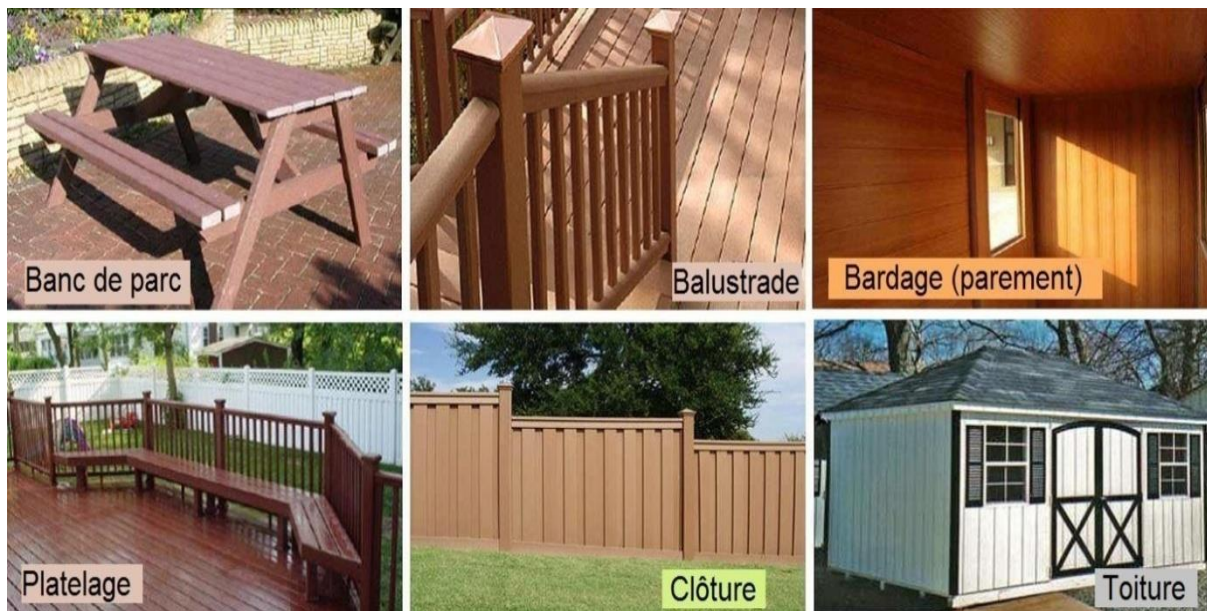
Figure (I.17) : Applications de plastiques renforcés de fibres naturelles dans les produits de construction [40].
