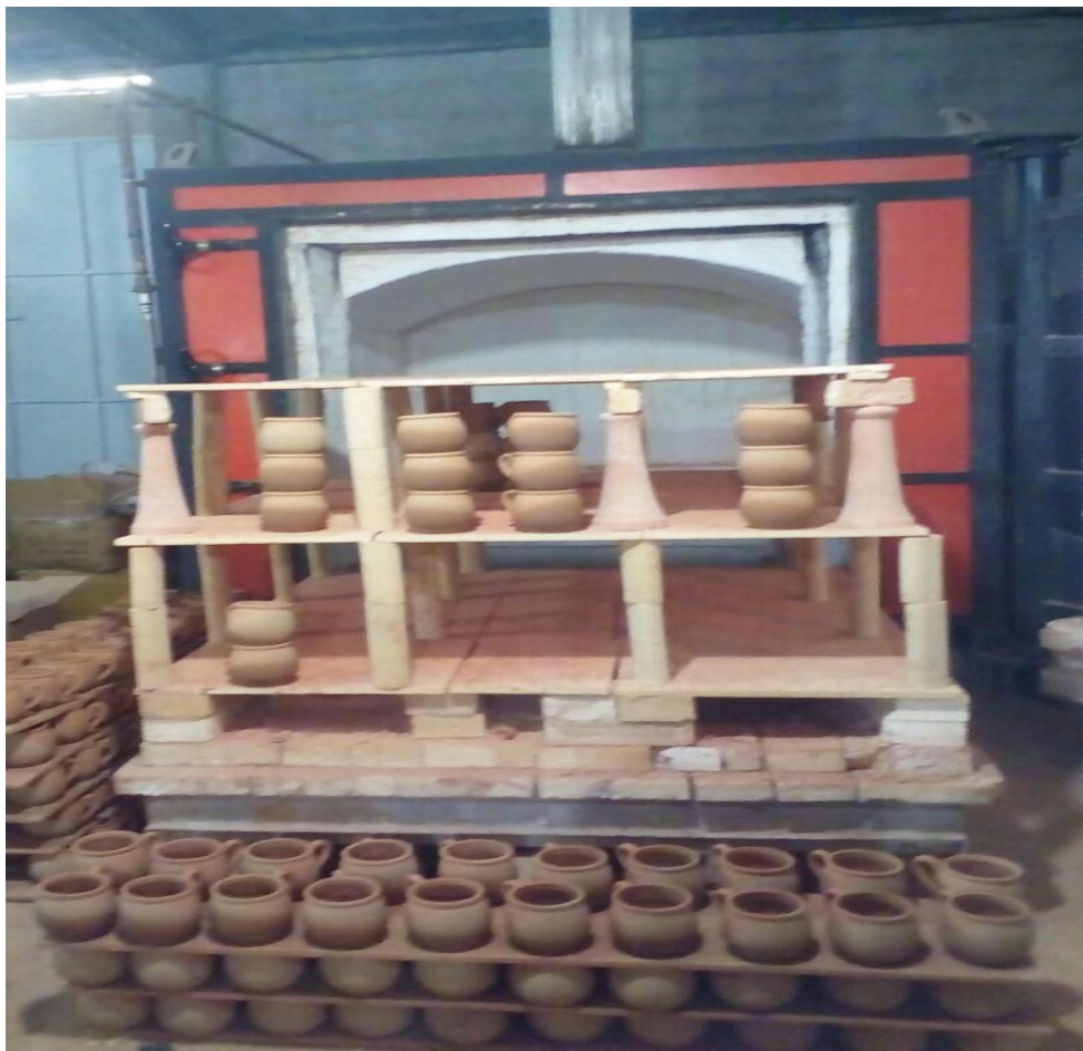
Fig.III.1 : Photo du four utilisé pour le séchage de la poterie à l'usine.
