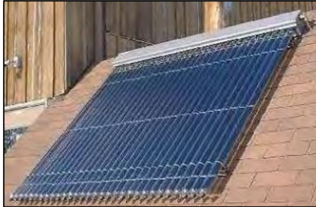
Figure.I.10. Capteur solaire à tubes sous vide [31]
