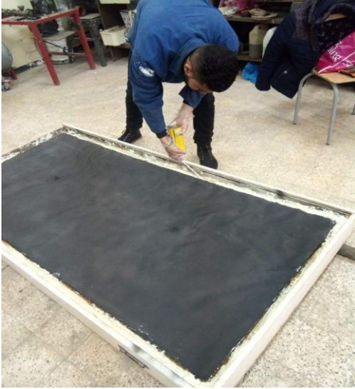
Figure III.4 : réalisation de l'isolation.
