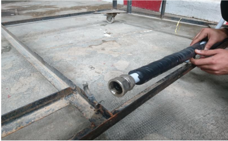
Figure III.14 : isolation des conduites de raccordement.
