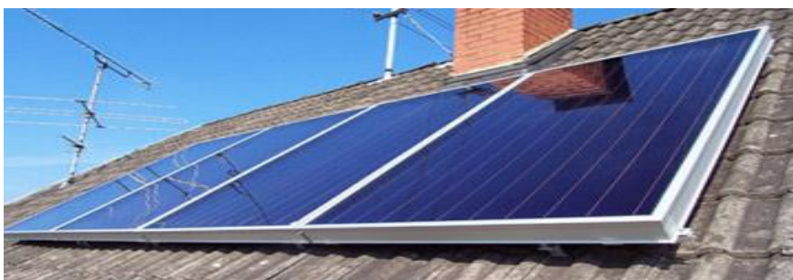
Figure I.7 : Capteur solaire à eau installé sur le toit d'une maison [9].
