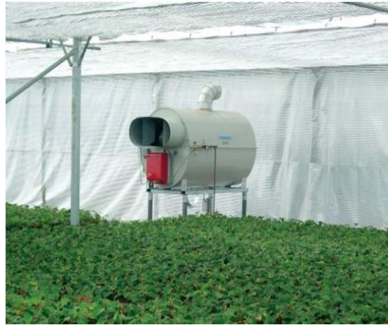
Figure I.8 : Exemple d'appareil de chauffage utilisé dans les serres [6].
