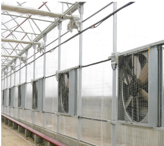
Figure I.6 : Ventilation par extracteur d'air [6]. Figure I.7 : Ventilation par des fenêtres automatiques [6].
