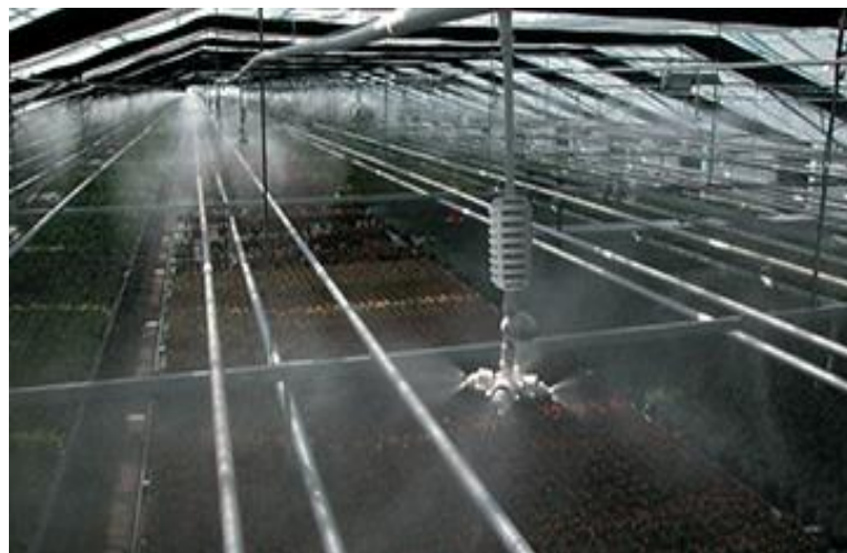
Figure I.11 : Brouillard basse pression [11].
