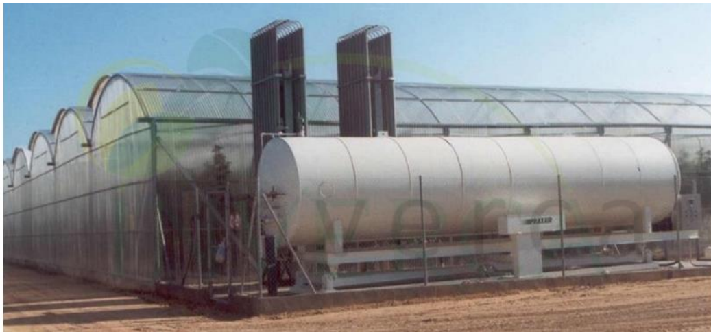
Figure I.14 : Réservoirs de CO 2 liquide [16].
