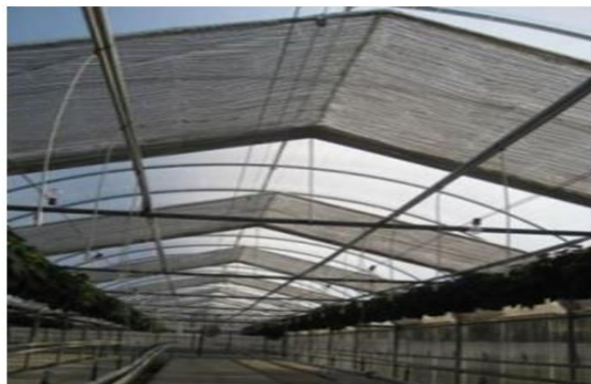
Figure I.9 : Rideaux utilisés dans les serres pour réduire la lumière du soleil [10].
