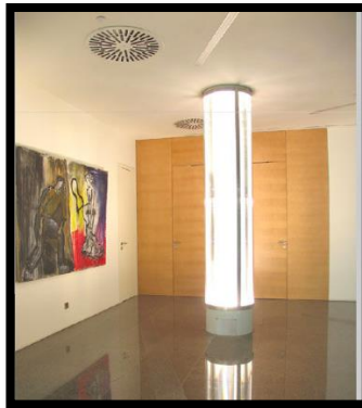
Figure 2-18 : Un conduit de lumière.
