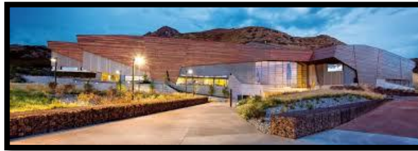
Figure 3-59 : Traitement de façade de musée «Utah Museum of Natural History». (Source : https://nhmu.utah.edu/rentals ).
