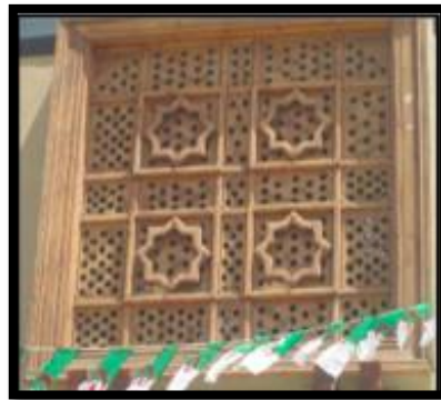
Figure 0-2 : Brise soleil utilisé dans l'orientations sud dans l'agence foncière.
