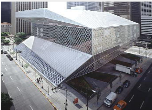
Entrée de parking
