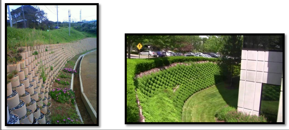
صورة 62: توضح شكل Landscape walls المرجع (دينا عيد سعيد خاطر-2014)
