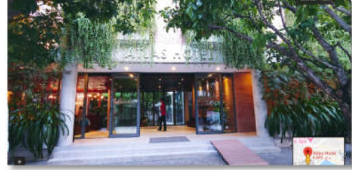
صورة 80: مدخل الفندق المرجع (2019 archidayli)
