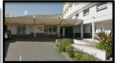
Accès aux urgences
