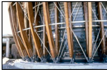
الصورة (7-II): أعمدة مبنى Centre cultural Tjibaou
