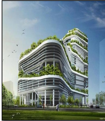
الصورة (14-ا): سقف مبنى أخضر المصدر: env-news-2016
