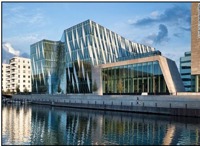
الصورة (16-ا): مبنى بالعمارة الذكية المصدر: كريمةان ط - 2009
