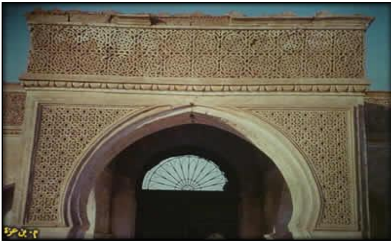
الصورة (7-1): أقواس الوادي المصدر: م. بن عزة 1990
