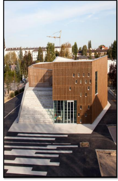
الصورة (I-24) : Nevers Cultural Centre, France المصدر: inhabitat-2012
