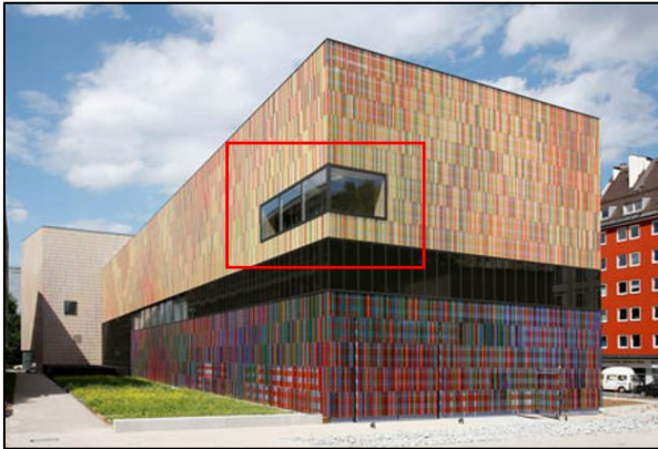
Figure III.25 : Fenêtre extérieur, Musée Brandhorst, Allemagne
