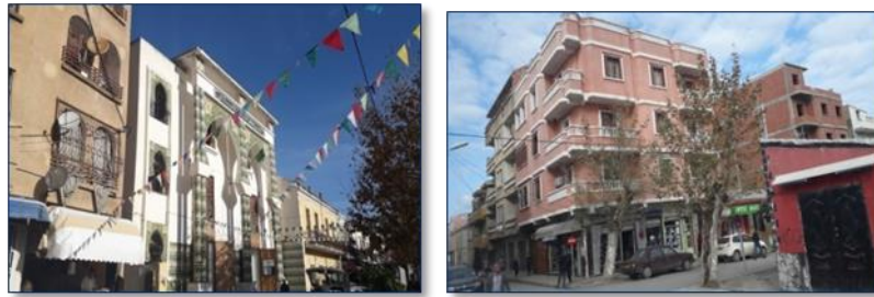
Photo 8 : Quelque exemple de nouvelle construction issu du processus Démolition/Reconstruction Source : Auteur (2018)
