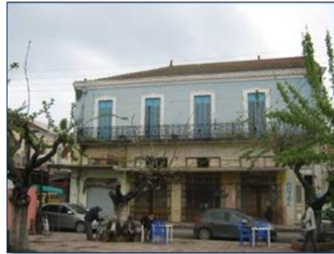
Photo 6 : Façade d'une maison coloniale Source : Auteur (2018)
