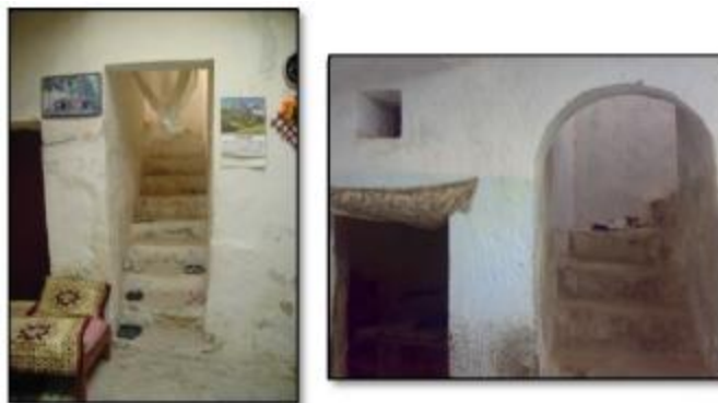
Fig(4.11) : Escaliers d' āmissiddār à la terrasse (Source : OGEBC Ouargla, 2013)
