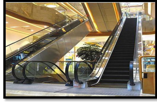
الشكل رقم 53-1 : سلاالم متحركة بمركز تجاري بالمانيا المصدر: https://www.panoramic-lift.com/escalator/electric-escalator/germany-kasper-escalator-with-handrail.html
