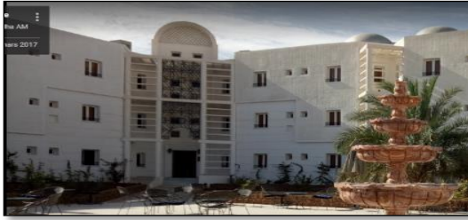
الشكل 02- 04: فندق ضاوييا المصدر: www.archdaily.com
