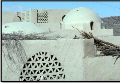
الصورة (59-II): الفتحات في الأسقف (المصدر: صلاح زيتون 1993)
