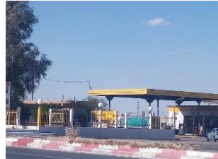
الصورة (67-II): محطة وقود (المصدر: الباحث 2019)
