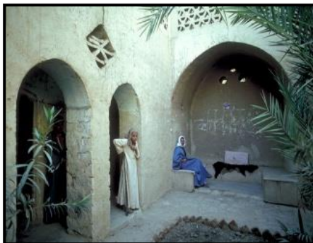
الصورة (II-58): الفناء (المصدر: صلاح زيتون 1993)
