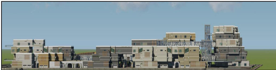
صورة 237: توضح الواجهة الجنوبية للمجمع السكني المصدر: الباحث 2019
