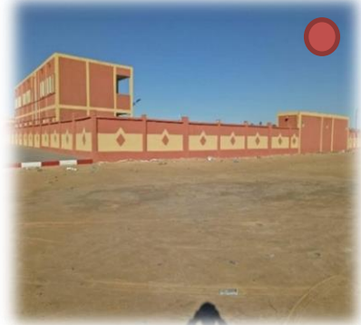
صورة 136: يحدها شمالا المدرسة والمسجد المصدر: الباحث 2019
