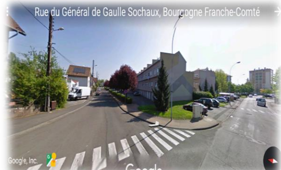
صورة 56: توضح مجال عام المصدر: قوقل ارث
