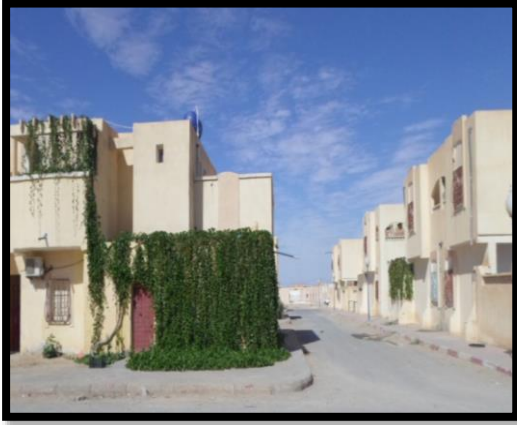
الصورة 04: مثال عن سكن نصف جماعي (المصدر : الباحث 2019)
