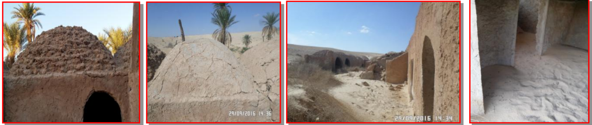
Photo (III-31) : le revêtement des murs et coupoles (Source : Auteur / 2017)
