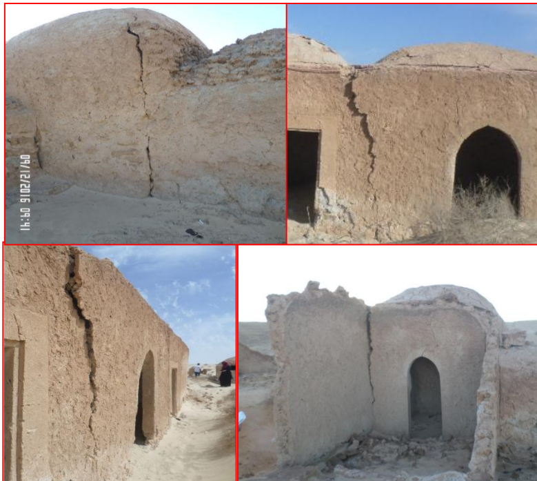
Photo (III-13) : exemple de déversement du mur
