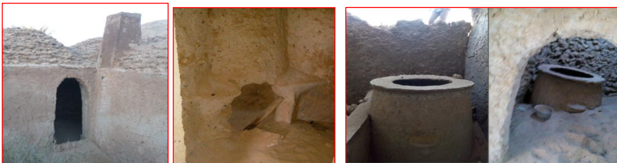
Photo (III-34) :khabya et cheminé / à droite une khabya
