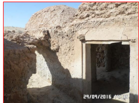
Photo (III-15) : des fissures au niveau des ouvertures.(Source : Auteur / 2017)
