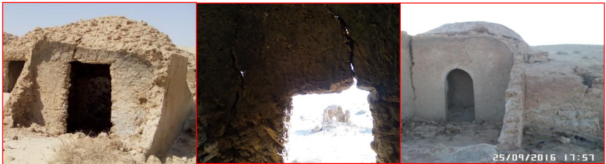
Photo (III-15) : des fissures au niveau des ouvertures.(Source : Auteur / 2017)
