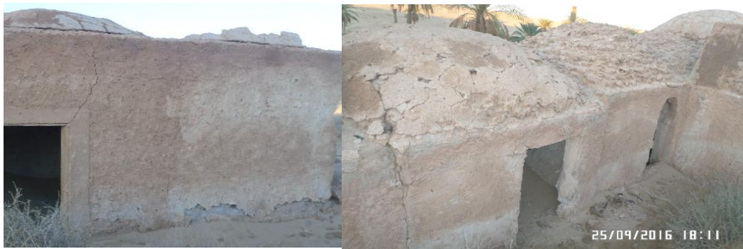
Photo (III-11) : formation des cristaux des sels a la surface du mur (Source : Auteur / 2017)
