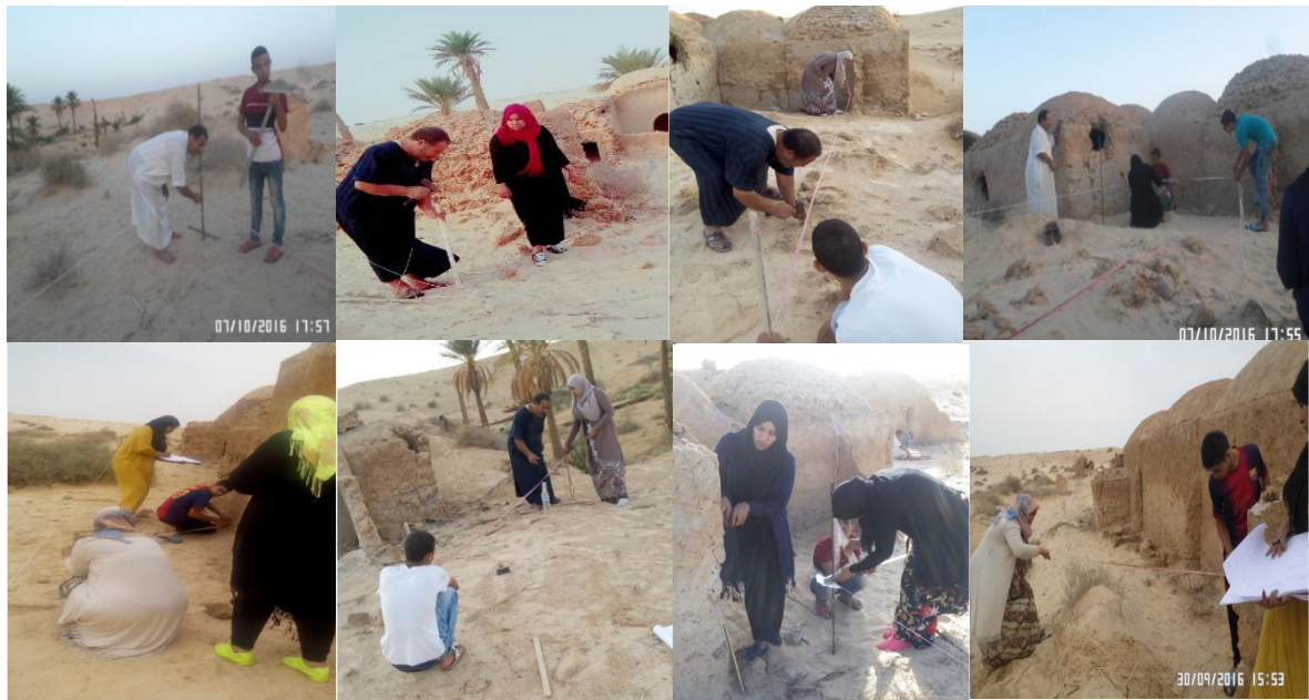
Photo (III-03) : l'application du relevé de la façade .Source : (Auteur / 2017)
