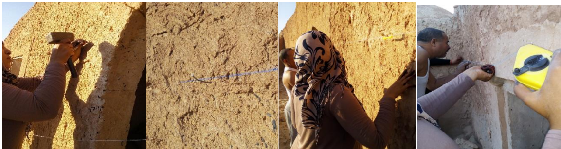
Photo (III -04) : l'application de la trace du niveau. (Source : Auteur / 2017)
