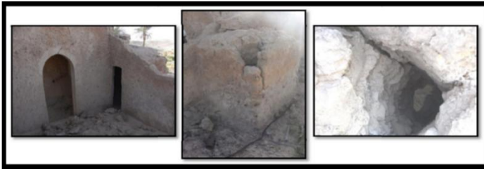
Photo (III-33) : les sanitaires et salles d'eau
