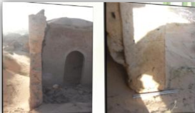
Photo (III-27) : épaisseur du mur extérieur (Source : Auteur / 2017)
