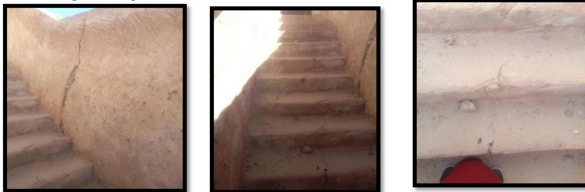
Fig.72.d'escalier, Source: auteure 2019
