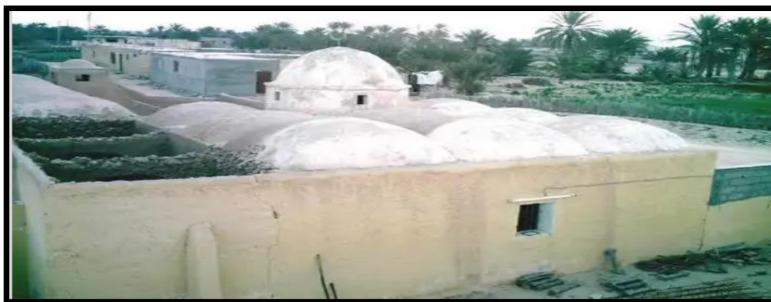
Fig.74de terrasse Source : auteure 2019
