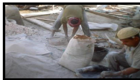
Fig. 116.Mur en Gypse_nu Source: auteur 2019
