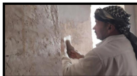
Fig. 117.Mur en Gypse_nu Source: auteur 2019
