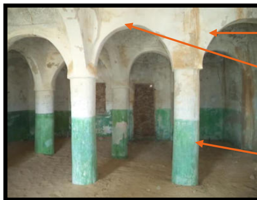
Fig32: Le système d'ossature dans la mosquée de Guemar
