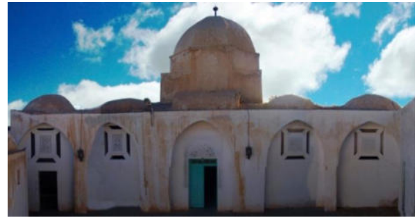
Fig.23 : Les façades de la mosquée
