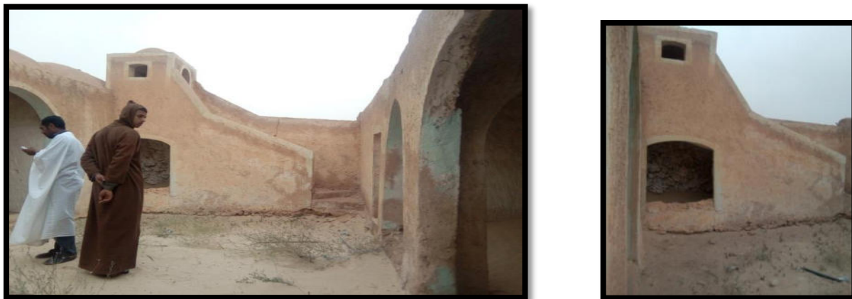
Fig.73.d'escalier, Source: auteure 2019
