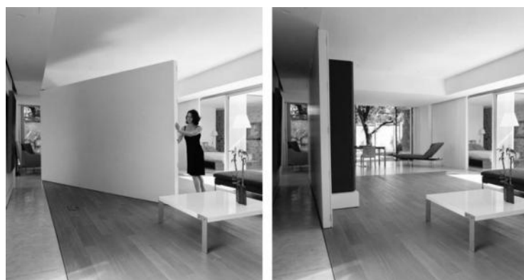
Figure 46 : cloison mobile pas démontable. Source : Alejandra Pumar Silveira
