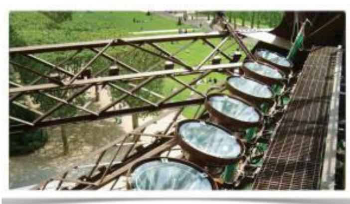
**Figure-10- Installation de projecteurs Aréna Vision conçus spécifiquement pour la tour Eiffel, à base de sodium 600 W.**
