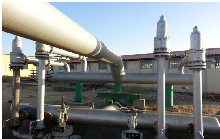
Figure I-4 : Les soupapes de sécurité
