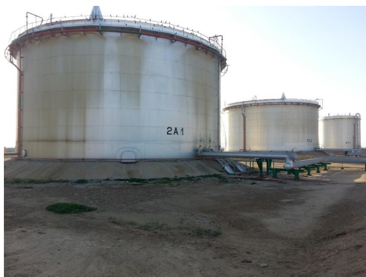
Figure I-9 : Les bacs de stockage
