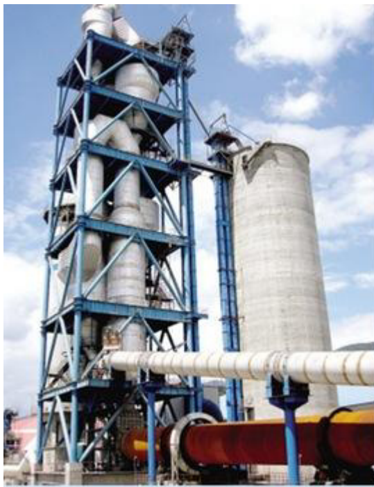
Figure 12: Préchauffeur ou cyclones[1]
