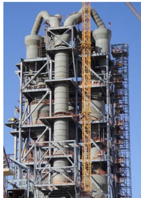
Figure 1.12: Préchauffeur ou cyclones
