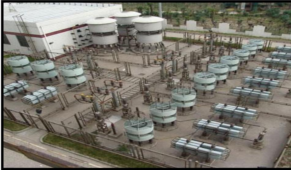
**Fig III.6 :** les compensateurs statiques de l'énergie réactive
