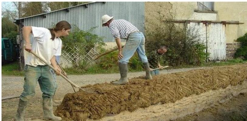
**Figure 1.3 :** Construction d'un mur en terre crue avec la technique de la bauge. (Permaculture Design, 2018)
