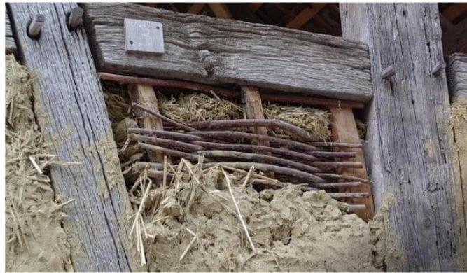
**Figure 1.1** : Mur en torchis en cours de réalisation qui laisse voir les tiges de bois obliques Entre les poteaux de l'ossature bois principale. (Permaculture Design, 2018)
