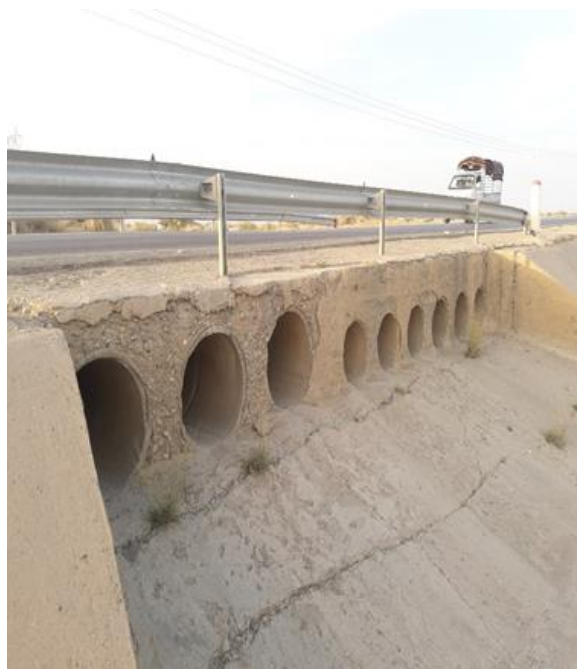
Photo IX.6 : Ouvrage Submersible.
