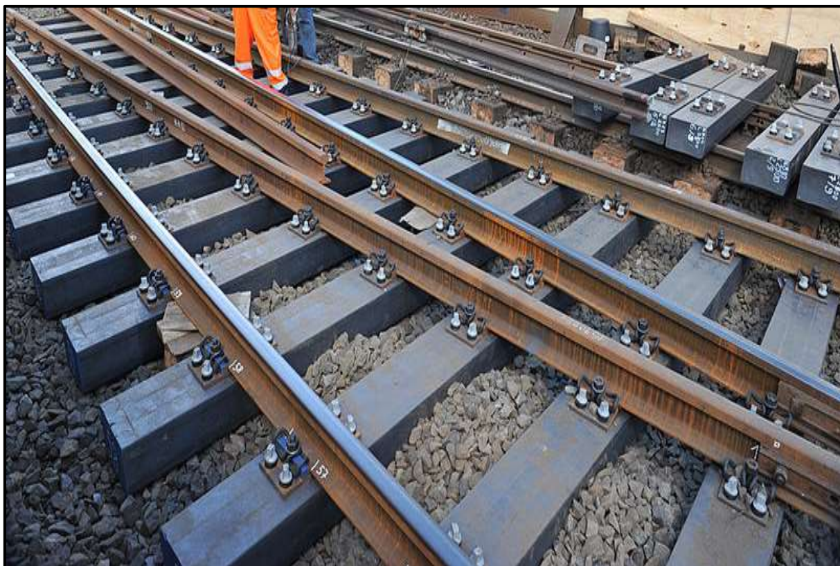
Figure 13 : traverses en plastiques ou composites
