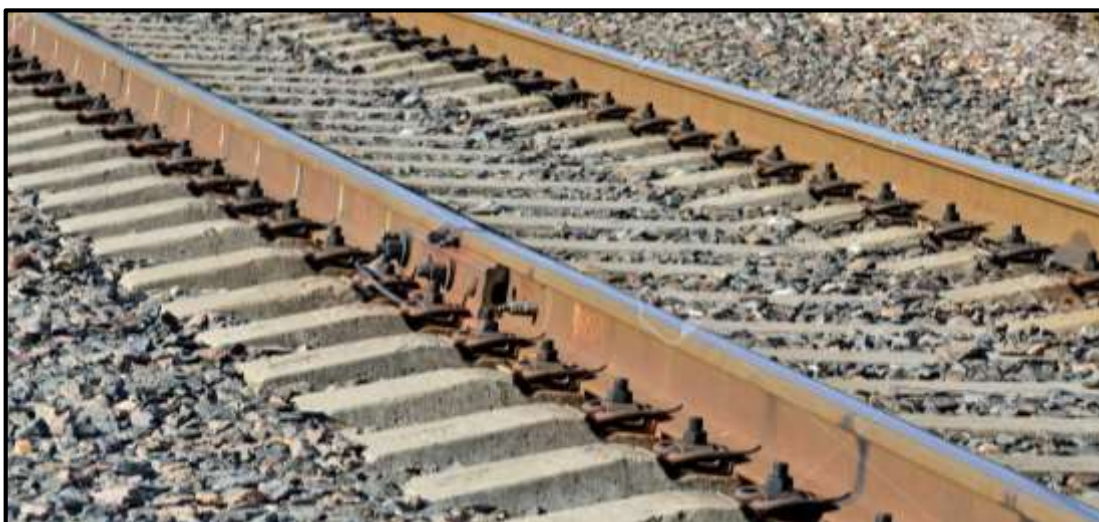
Figure 11 : traverses de béton armé
