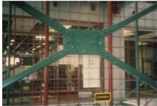
Figure 1.7 i) L'amortisseur de Sumitomo .Aiken et al. [4]
