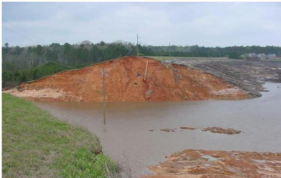
Figure (II-17) : Rupture de barrage de BigBay (Internet)
