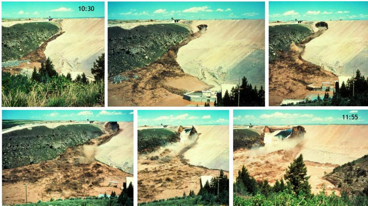
**Figure (II-15) :** Etapes de la rupture du barrage « Teton dam » : des premiers signes d'érosion visibles près du socle rocheux, jusqu'à la rupture et l'inondation, via l'apparition de l'écoulement boueux et l'élargissement de la brèche.
