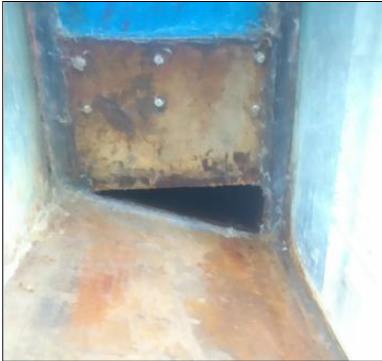
Photographie (1.5) : convergent du canal.
