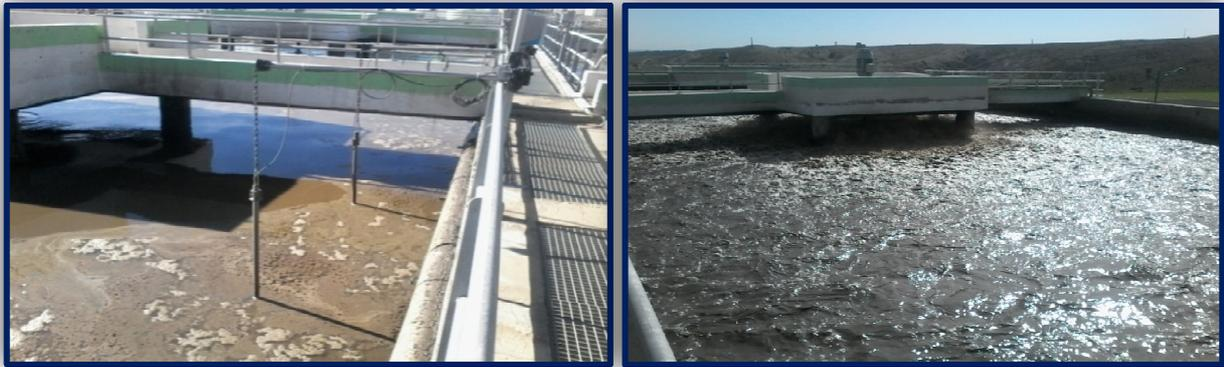
**Figure 20:** bassin d'aération a boue active (Cliché par ZORAI, 2019).
