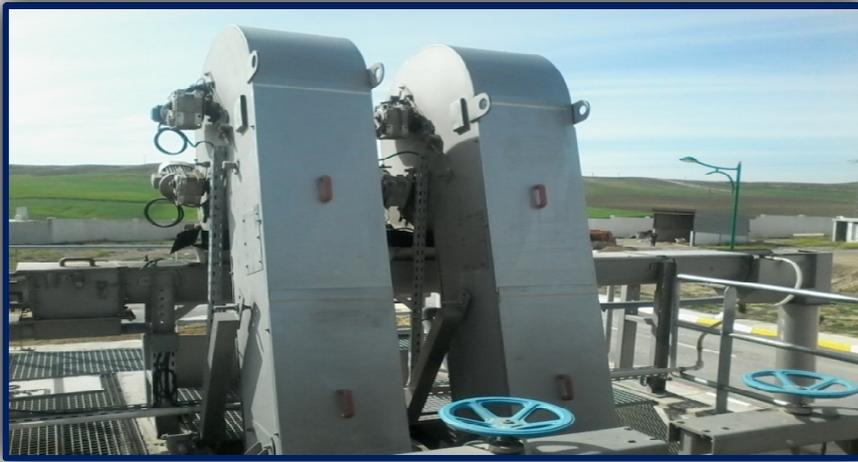
**Figure 13:** Grilles mécaniques (E.H.T, 2013) (Cliché par ZORAI, 2019).
