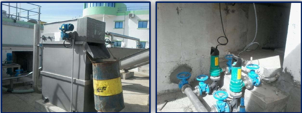
**Figure 17:** Evacuation des huiles et graisses (Cliché par ZORAI, 2019).
