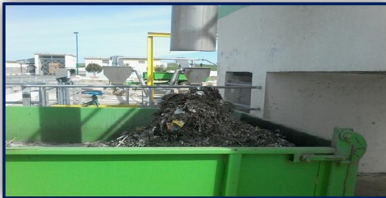
**Figure 14:** Refus de dégrillage (Cliché par ZORAI, 2019).
