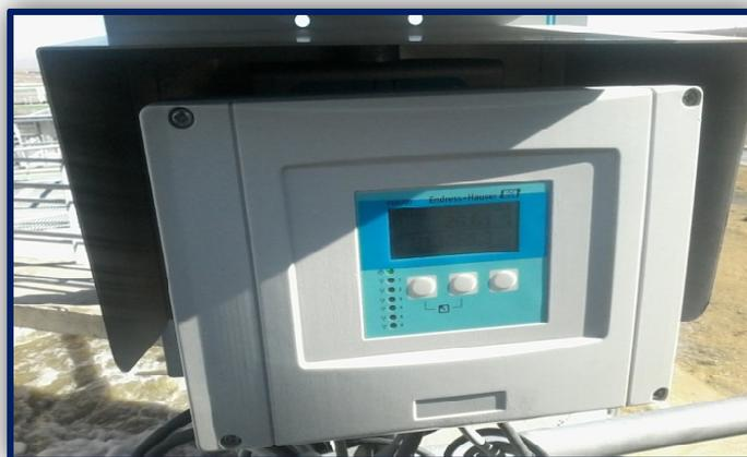
**Figure 12 :** débitmètre électromagnétique (E.H.T, 2013) (Cliché par ZORAI, 2019).
