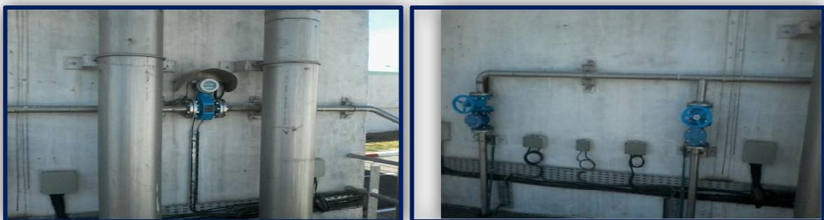
**Figure 25:** Poste de pompage des boues (recirculation/extraction)
