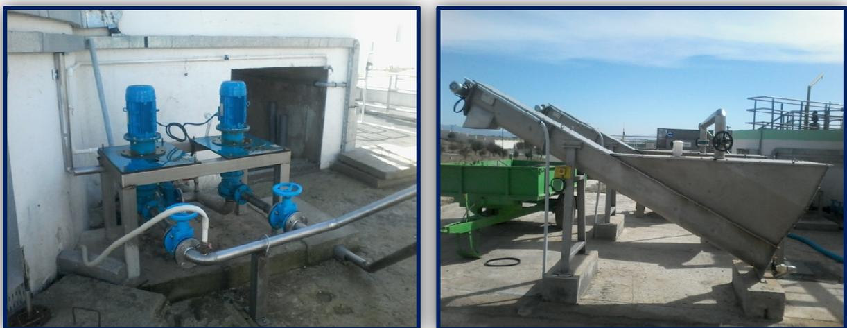
Figure 16: Système d'extraction et d'évacuation des sables (Cliché par ZORAI, 2019).
