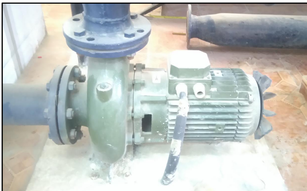
Photo (1.2) : Pompe centrifuge axiale.
