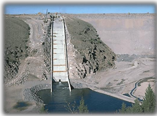
(a) Vue sur le barrage de Teton (USA) avant
