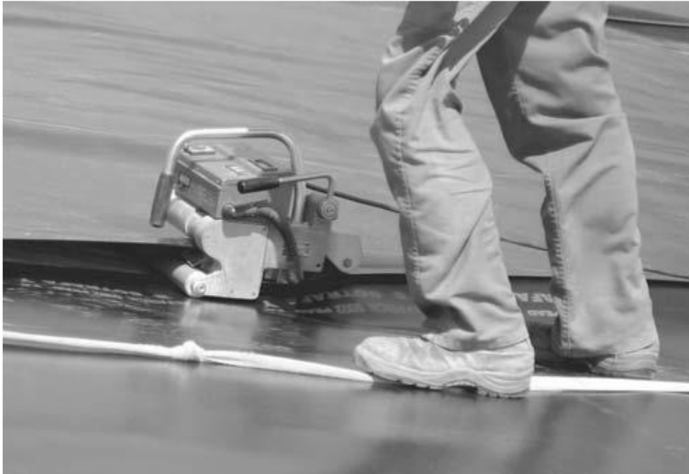
Figure II.13: Photographie du sertissage des coins des membranes de géomembranes en PEHD soudeur (vue de côté). Reproduit avec la permission de Sotrafa.(Sheirs.j ,2000)
