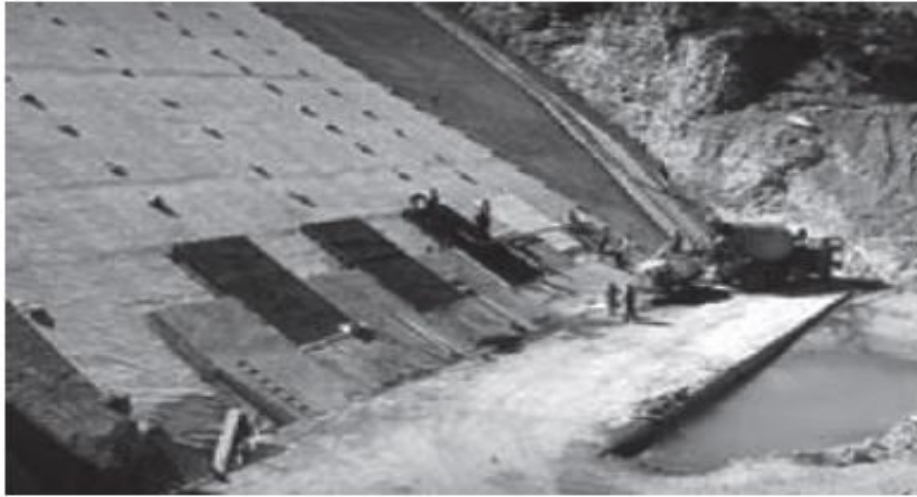
Figure II.12 : Barrage de Bovilla, Albanie 1996, nouvelle construction: des dalles en de béton non renforcées sont moulées in situ au-dessus d'un géotextile protégeant le géocomposite de PVC contre bétonnage. (ICOLD / CIGB, 2010)
