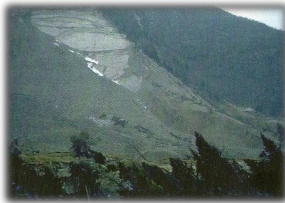
Figure I.04 : Glissement en rive gauche du barrage du Vajont (hydropower & dams)
