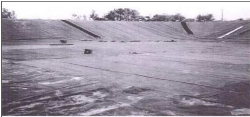
Figure II.08 : Exemple d'une géomembrane posée dans un bassin. (Rollin et al., 2002)
