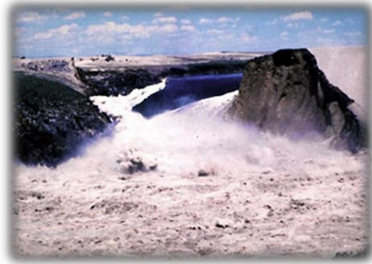
(b) Rupture du barrage
