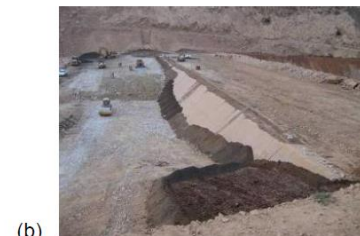
Vue du batardeau en construction.
