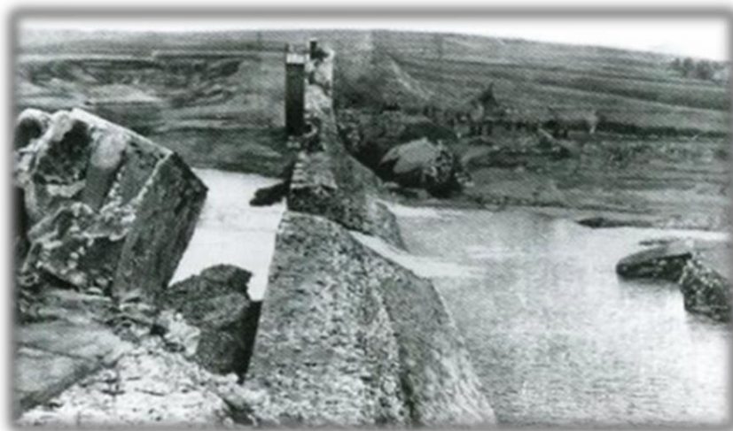
Figure I.03 : La rupture du barrage de Bouzey (Deroo L. 2011).
