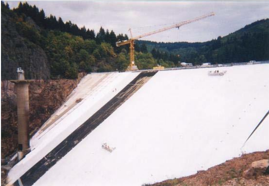
Figure III.04 : Barrage du Rouchain réfection du masque amont par géomembrane protégée.
