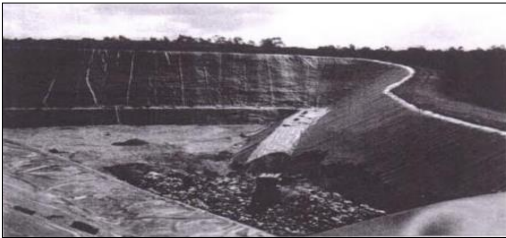
Figure II.09 : Exemple d'une cellule de confinement de déchets : fond et parois. (Rollin et al., 2002)
