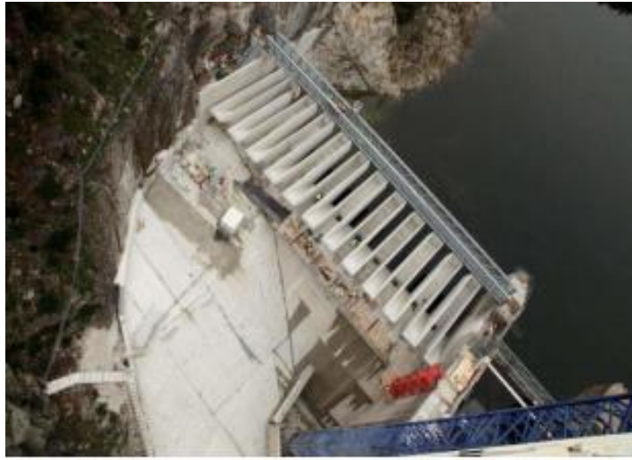
Figure I. 6: Déversoir en touches de piano (Laugier et al, 2009)
