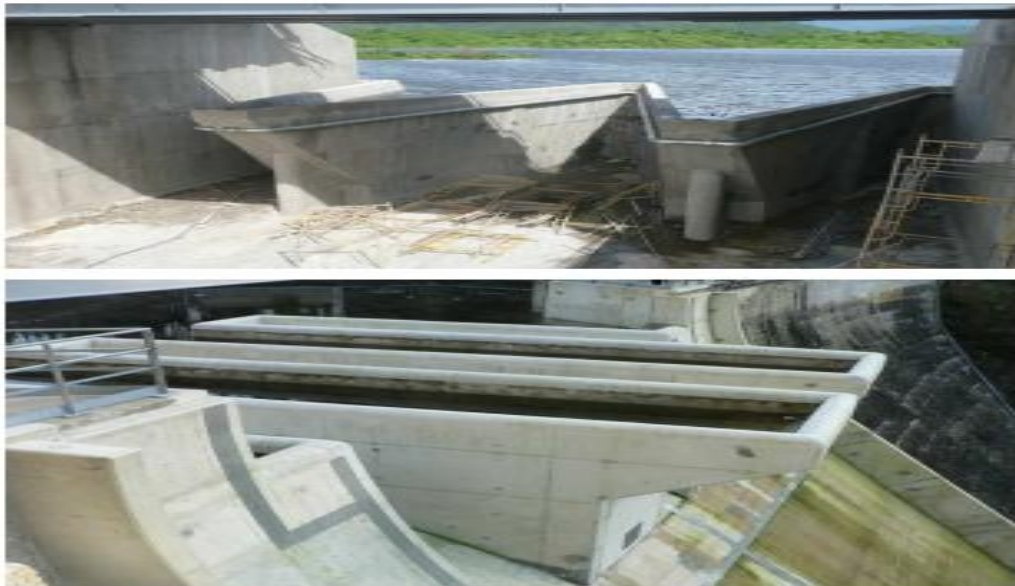
Figure (II.13) : photo supérieure : déversoir en labyrinthe du barrage de Song Mong (Vitenam) & photo inférieure : déversoir en touches de piano du barrage de l'Etroit (France) – (banque de photos du HECE).
