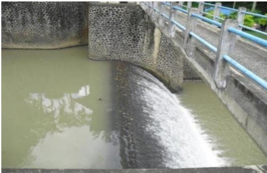
*Figure I.01 : Ecoulement sur un déversoir rectiligne (Creager).*
