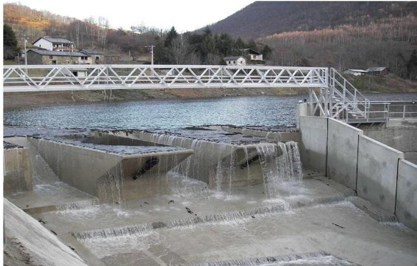
**Figure II.11** : Piano Key Weir sur barrage Goulours (EDF – France)
