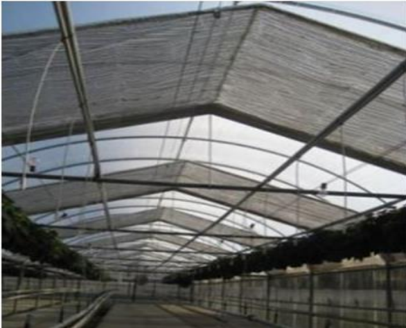
Fig. 13 : Rideaux utilisés dans les serres pour réduire la lumière du soleil (ULMA, 2018).
