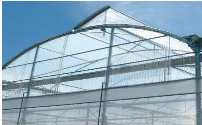
Fig.16 : ouverture sur le faîtage(ULMA. ,2018)
