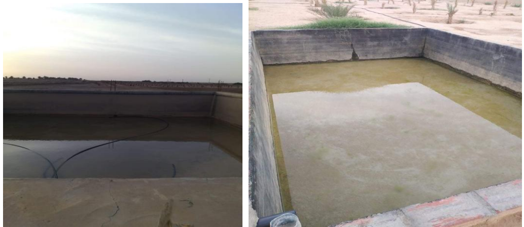
Figure 13 et 14 : un bassin d'accumulation d'eau
