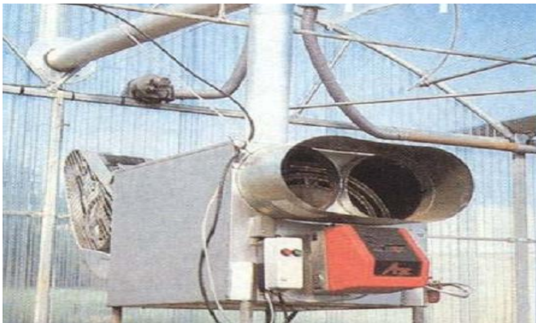
Figure 04 : Un chauffage d'air (Sophie C).
