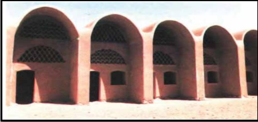
الصورة رقم(02): حماية الحوائط والفتحات الخارجية من أشعة الشمس
