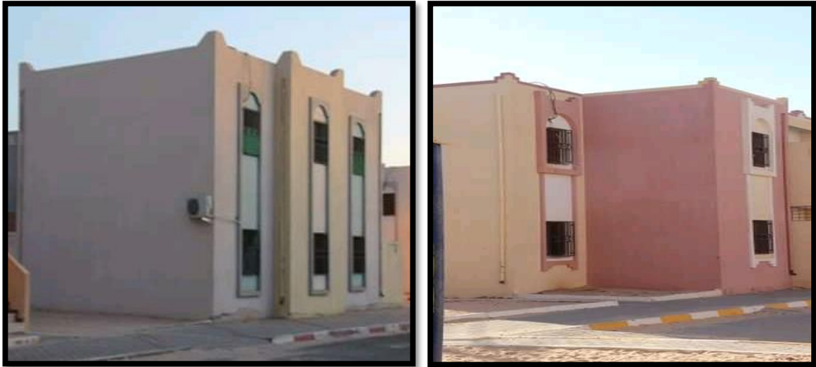
الصورة رقم (50) و(51): نمط بناء بمواد محلية بحي 470 مسكن
