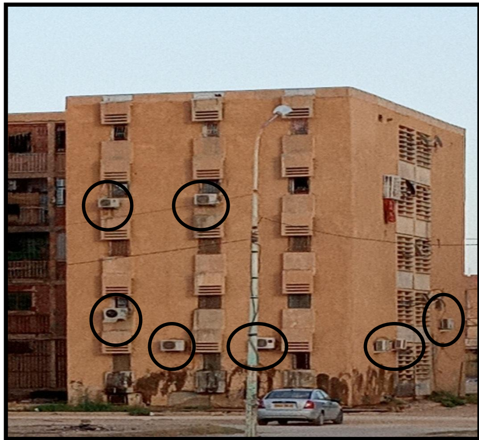
صورة (21): إستخدام المكيفات الهوائية الكهربائية لتلطيف الجو الداخلي في فصل الصيف
