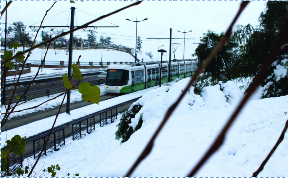
الصورة (23): ترامواي قسنطينة
