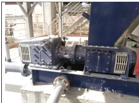
Figure III.6 : Image réel de la pompe sur site
