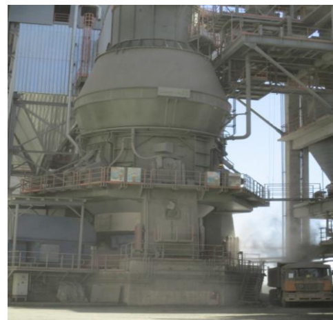
Figure I.13 : Broyeur de clinker Le VCM [1].
