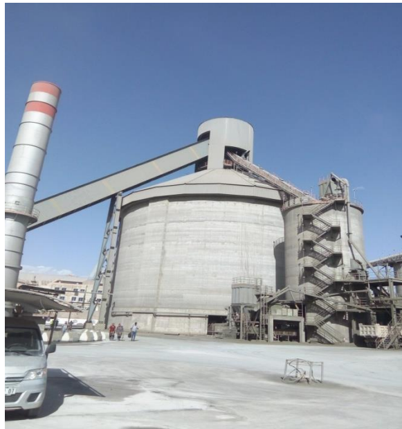
Figure I.12 : Un Silo de stockage de clinker [1].
