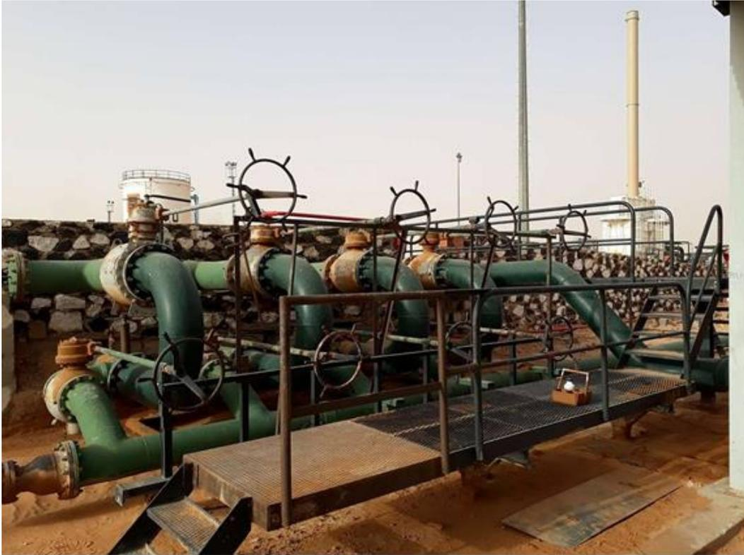
*Figure I.8: jeu de vannes (production et expédition)*
